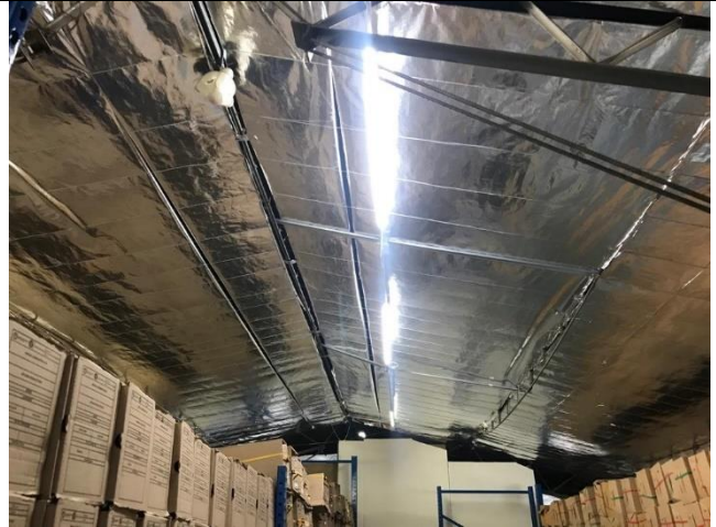
Fotografía 26. Cubierta aislante último nivel
